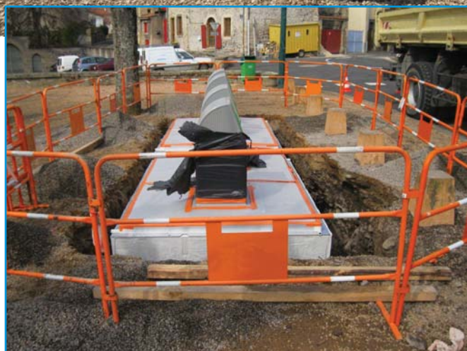
Vue sur les conteneurs pendant l'installation ▲
